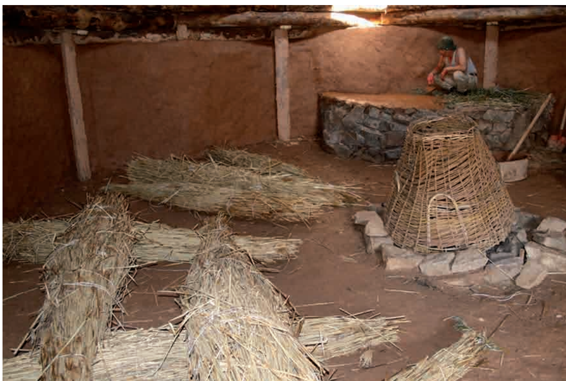
Рис. 9. Утепление пола экспериментального жилища камышом. Ботай, 2021 г. Фото К.Г. Абилямаликова
